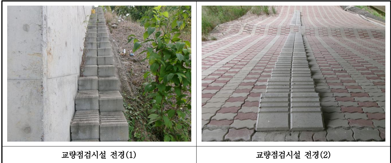
【사진 27.3.26】 교량 점검시설 전경
