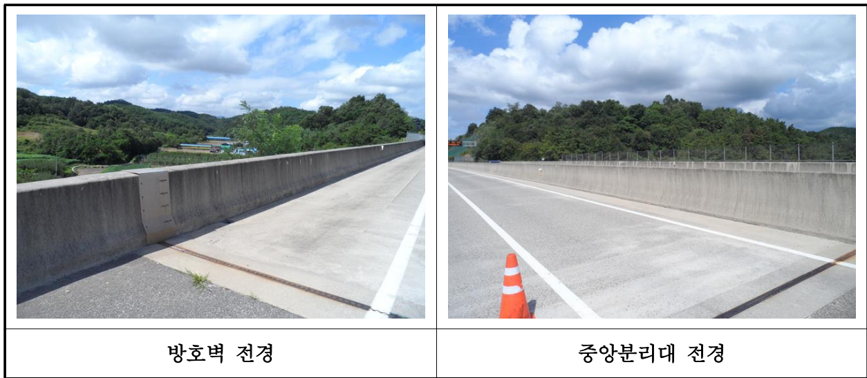
【사진 27.3.51】 방호벽 및 중앙분리대 전경
