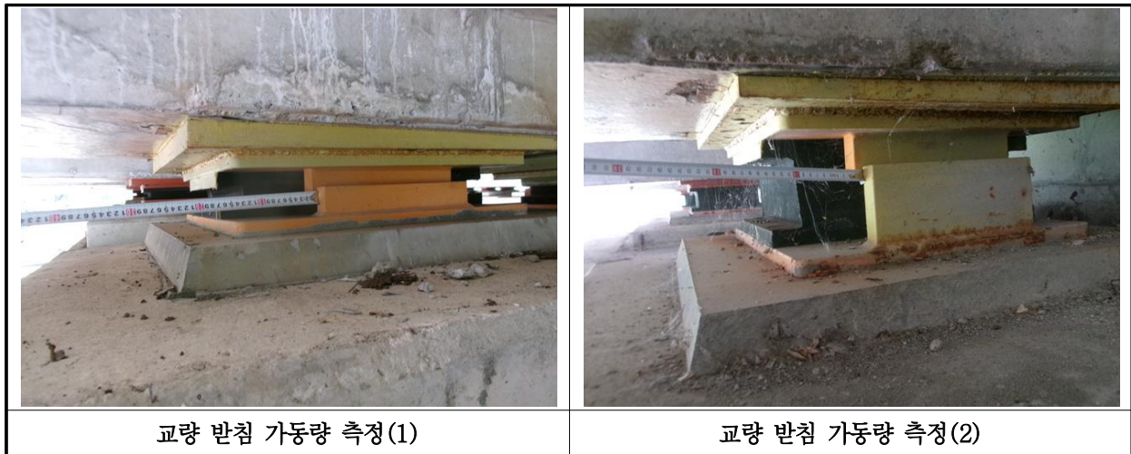
【사진 27.3.43】 교량받침 이동량 측정
