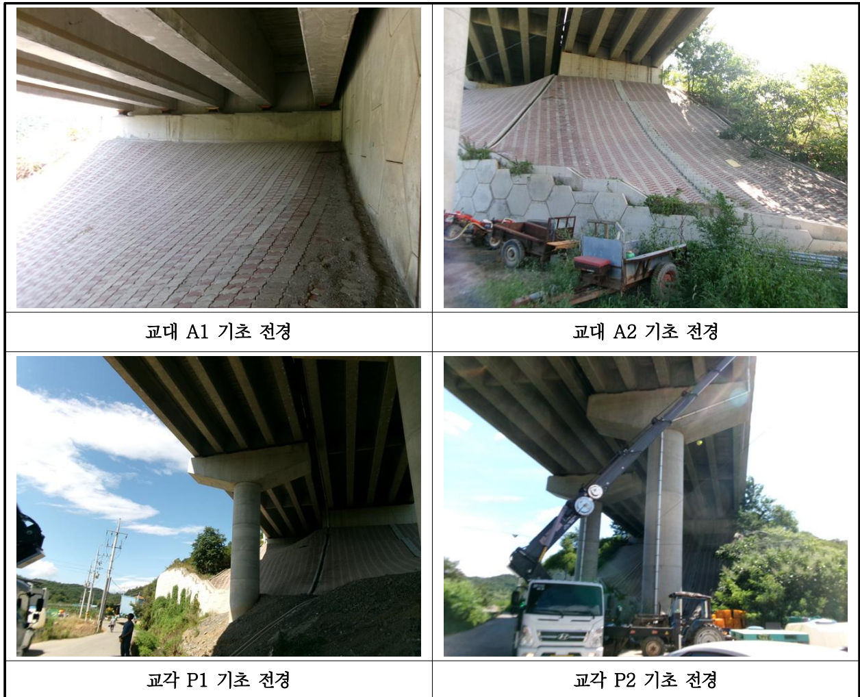
【사진 27.3.39】 기초 전경
