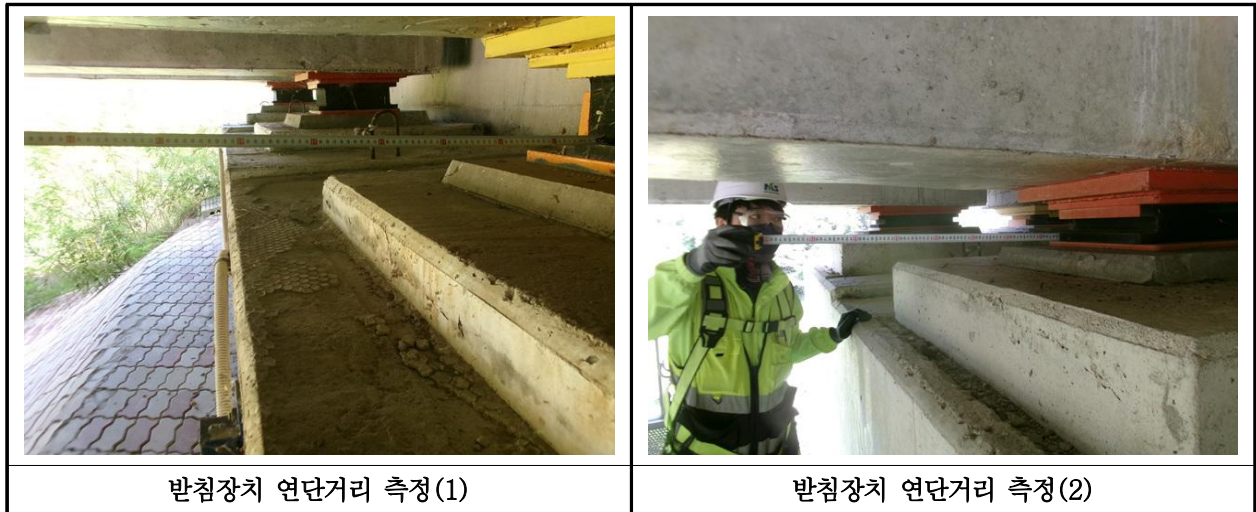
【사진 27.3.15】 교량받침장치 연단거리측정
