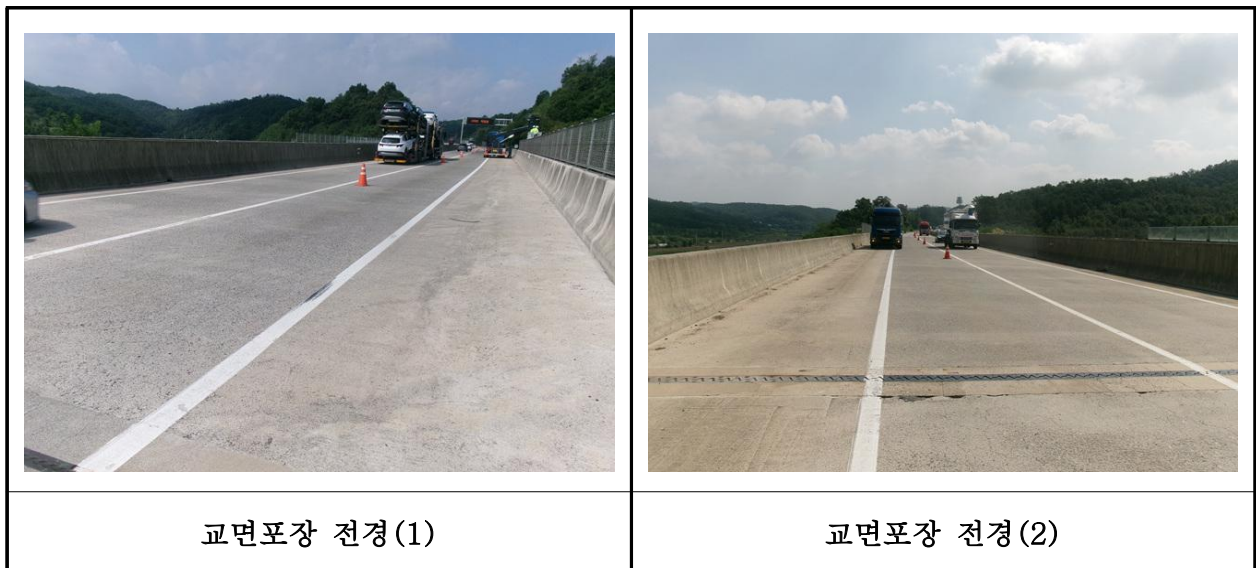
【사진 27.3.20】 교면포장 전경
