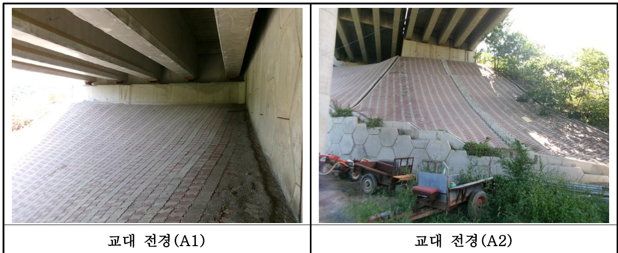
【사진 27.3.35】 교대 전경
