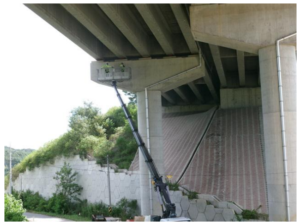
부재 현장측정 전경
