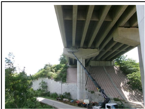
부재 현장측정 전경
