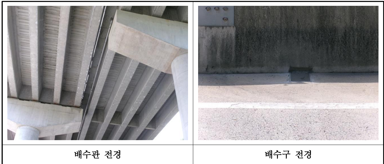
【사진 27.3.22】 배수시설 전경
