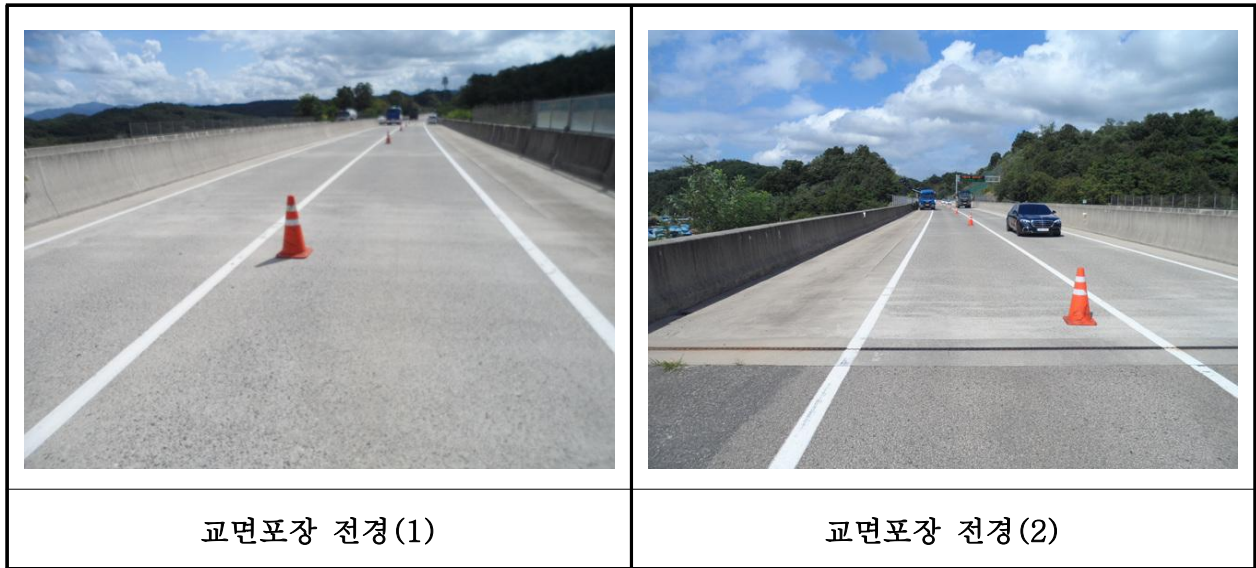
【사진 27.3.47】 교면포장 전경
