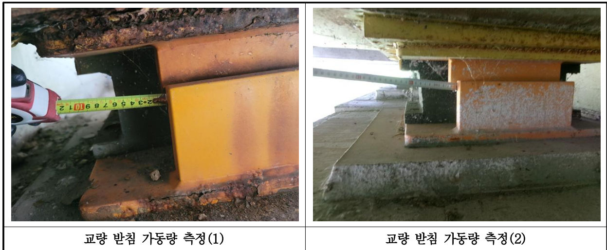
【사진 27.3.16】 교량받침 이동량 측정
