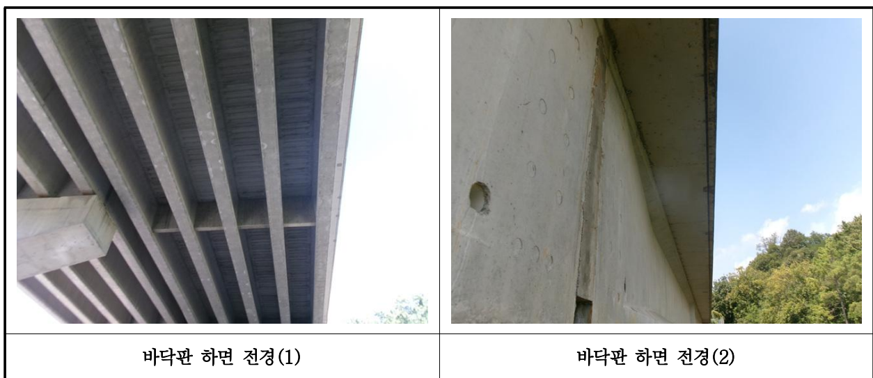
【사진 27.3.2】 바닥판하면 전경
