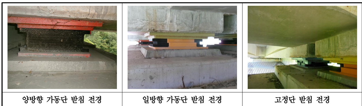
【사진 27.3.13】 교량받침 전경
