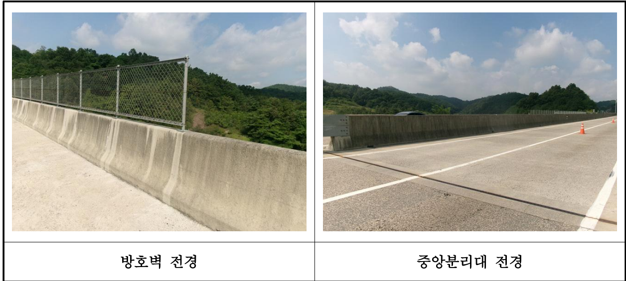
【사진 27.3.24】 방호벽 및 중앙분리대 전경
