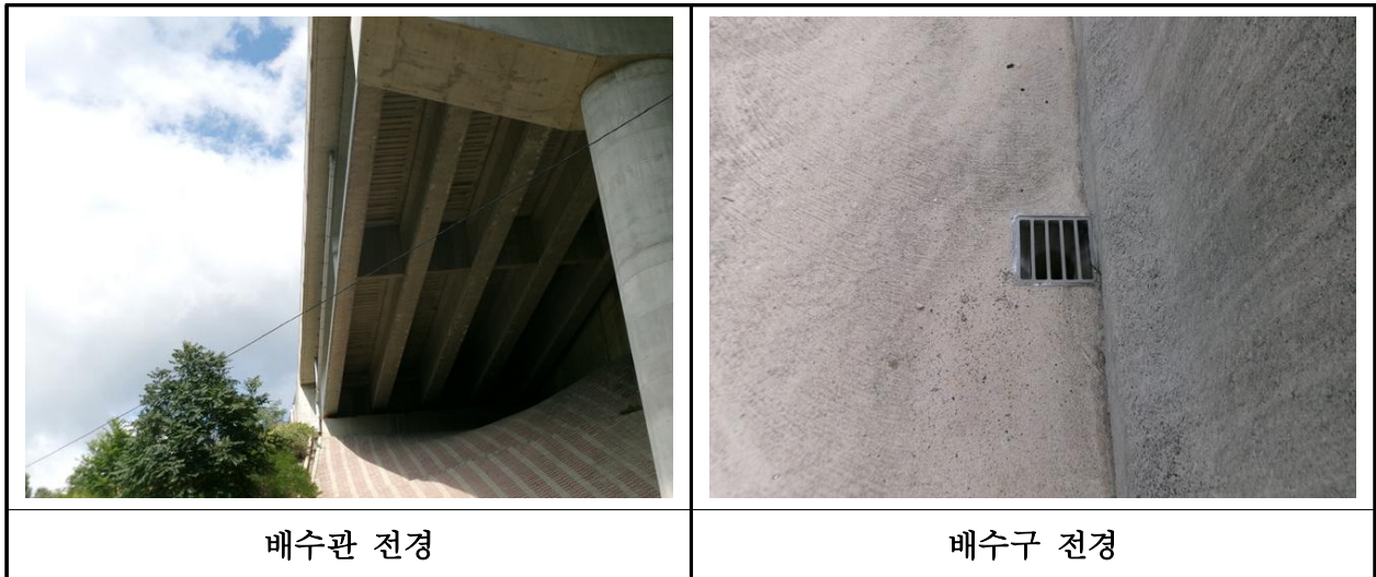
【사진 27.3.49】 배수시설 전경
