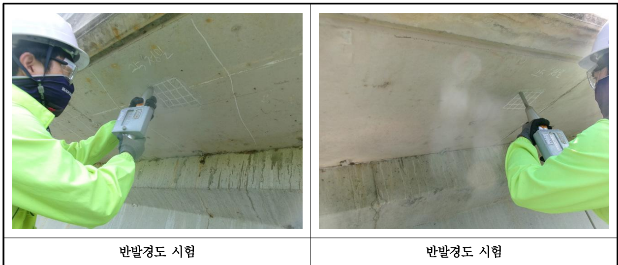
【사진 27.4.2】 반발경도시험 현장사진
